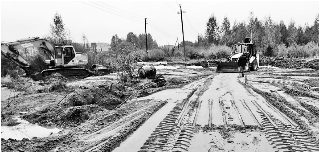
установлены дорожные знаки. Укладка дорожных плит для осуществления дальнейших работ завершена. Также в местах пересечения с дорогами размещены водопропускные трубы, расположенные под дорогой.
